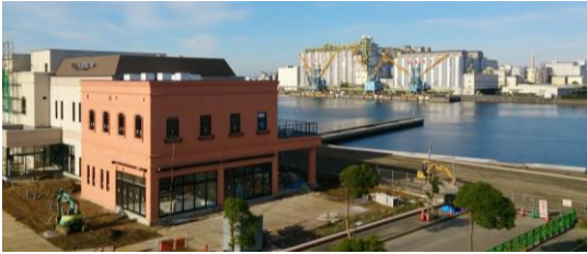
▼建設中の旅客船ターミナル複合施設
