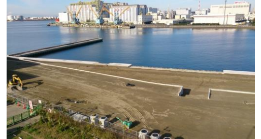
千葉中央港の港湾緑地・さん橋整備現場▼
