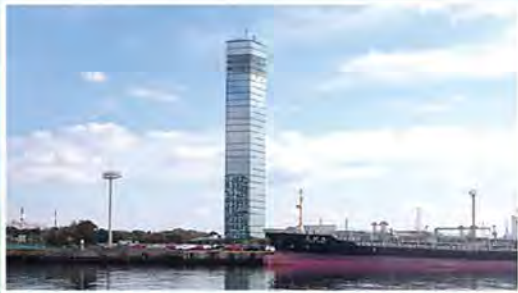
④ 千葉ポートタワー
