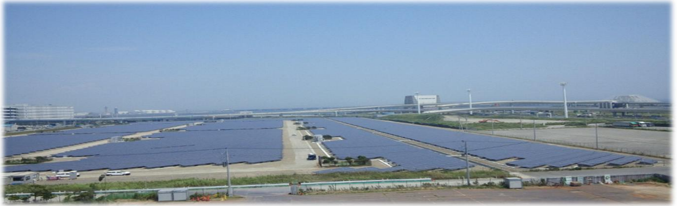
提案で示した川崎区浮島町メガソーラー発電所
