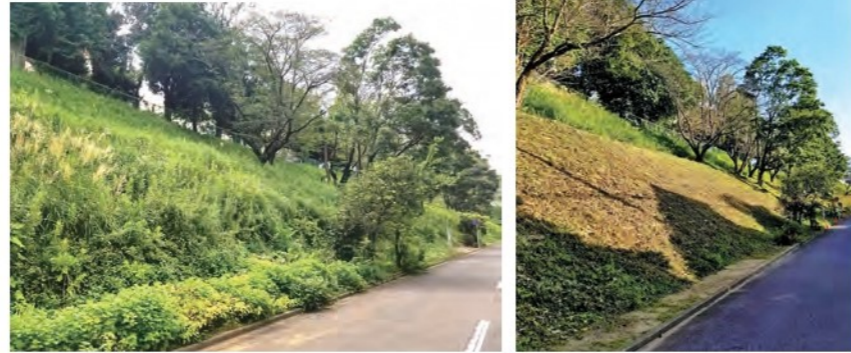
仁戸名小学校 西側法面
